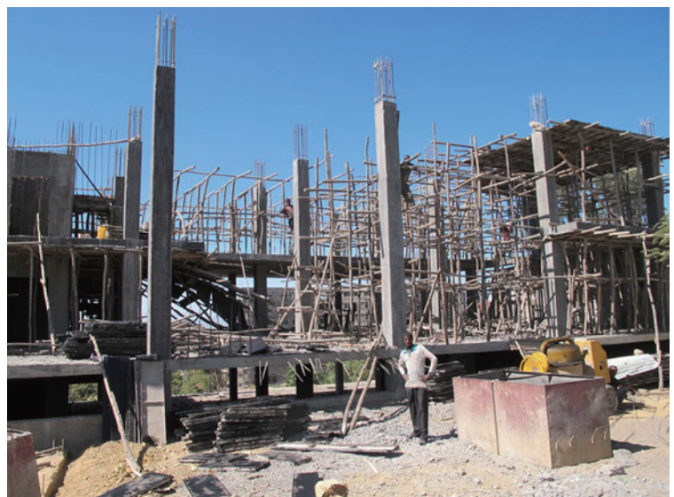
写真3 多層建築に利用されるユーカリ木建築用材（メケレ：H26.10）
